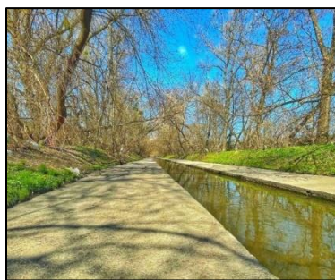
Рис. 2. Бетонний жолоб р. Либідь
