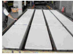
елементи із комірчастого бетону, що вкладені на нижній важкий бетон
