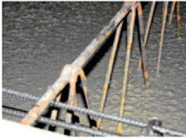
уцілений свіжий бетон нижчого рівня
