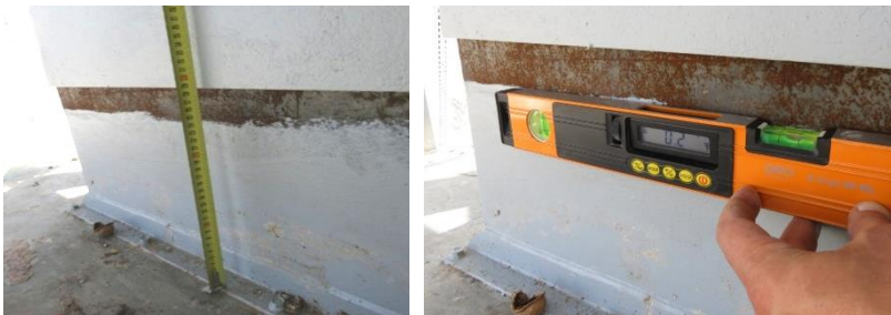
Рис. 2.14. Вимірювання крену завантажувального оголовку башти силосу
