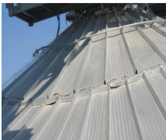
Рис. 2.7. Деформації та прогини ребер жорсткості покриття силосу
