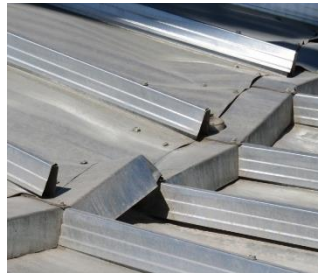
Рис. 2.6. Наявність значних прогинів системи покриття башти силосу
