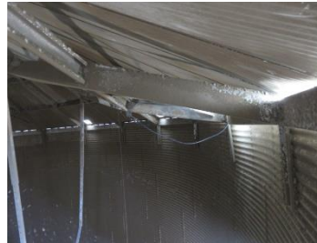
Рис. 2.6. Наявність значних прогинів системи покриття башти силосу
