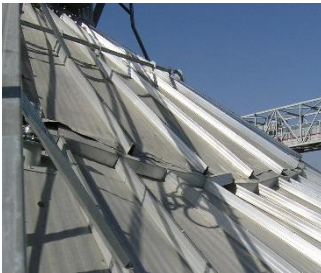
Рис. 2.6. Наявність значних прогинів системи покриття башти силосу
