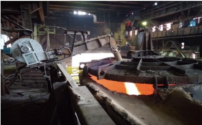
Рис. 1. Пальник ГНБ-1400 в кришці 250-ти тонного ковша
